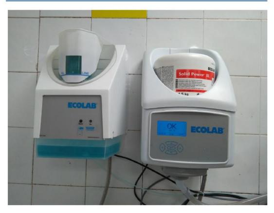
La señal del dosificador de detergente se conecta a una fase del contactor de la Bomba de lavado y al neutro de la regleta de conexiones (NO1).
